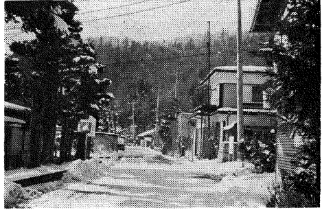
旧道沿いの鳴沢集落
