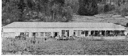
改築時の保育所（旧小学校舎）昭和47年 4月
