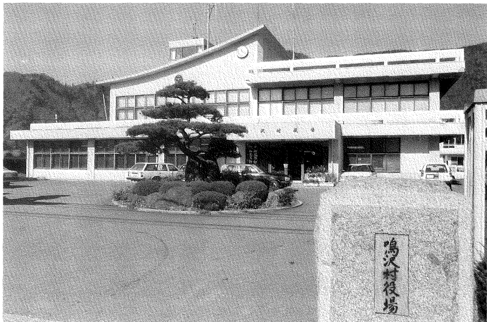
鳴沢村役場庁舎
