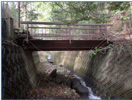
西白田和 1 号橋（村道 170 号線）
