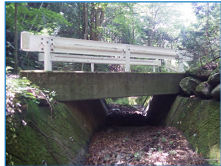
西白田和 2 号橋（村道 164 号線）
