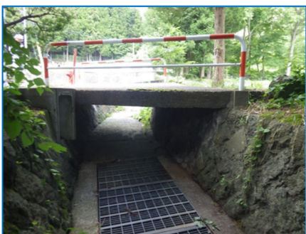
水上 1 号橋 (村道 311 号線)
