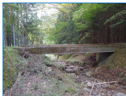
水神堀内橋 (村道 311 号線)
