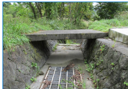
水上 2 号橋 (村道 133 号線)
