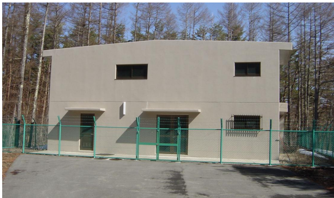
三本松配水池
