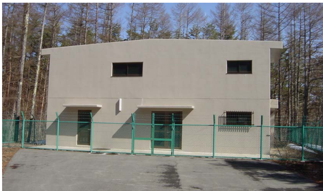
三本松配水池
