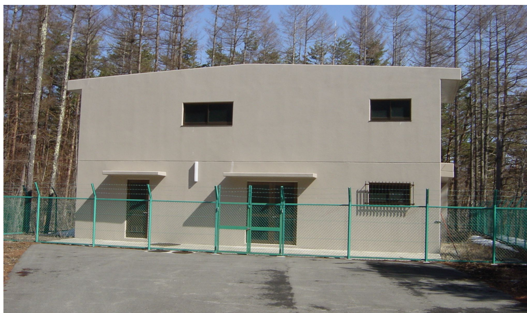
三本松配水池
