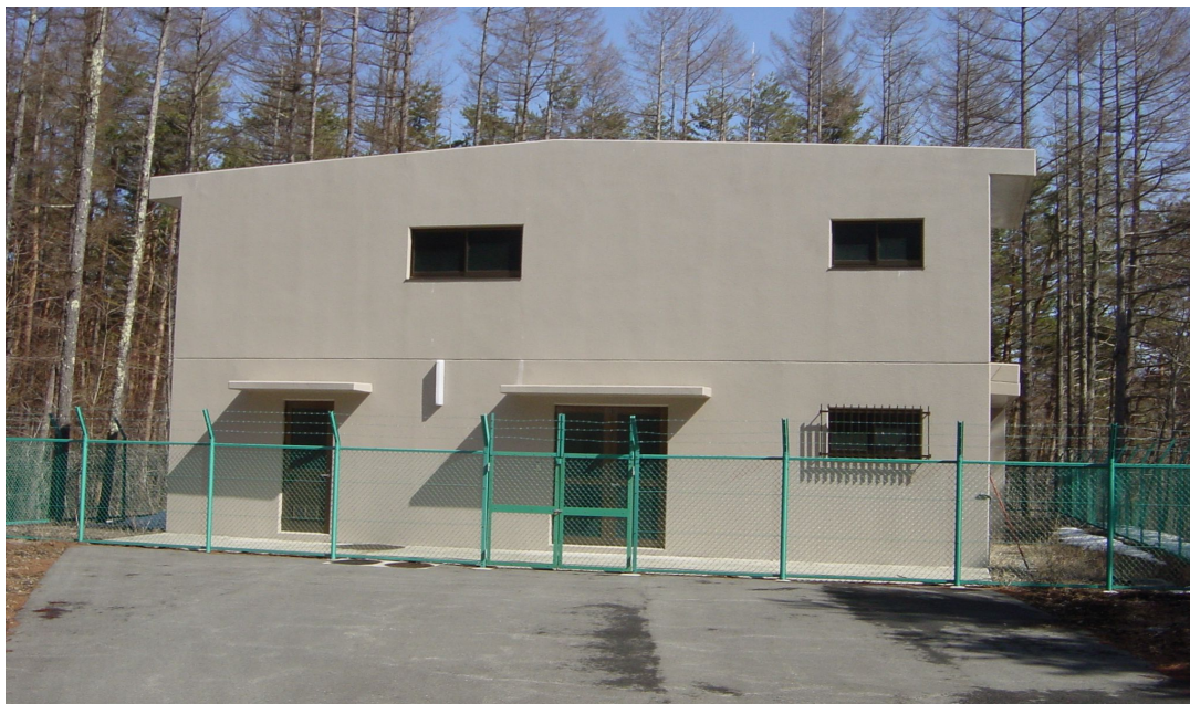
三本松配水池
