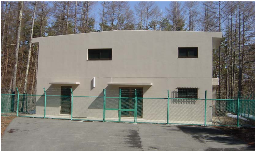
三本松配水池
