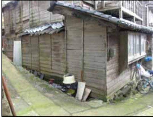
外壁が裸木造の例
