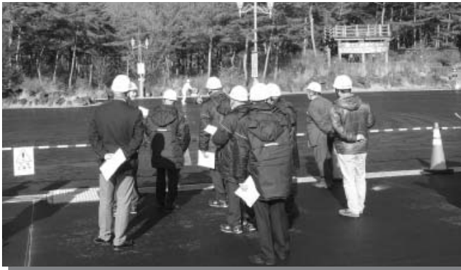
昨年12月に道の駅駐車場工事の進捗状況を視察
