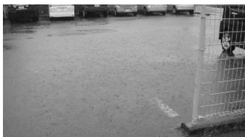
雨で水浸しになる保育所駐車場
