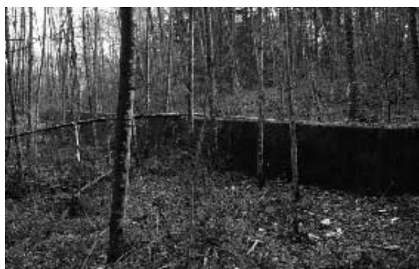
ゴルフ場開発跡地に残る堰堤
