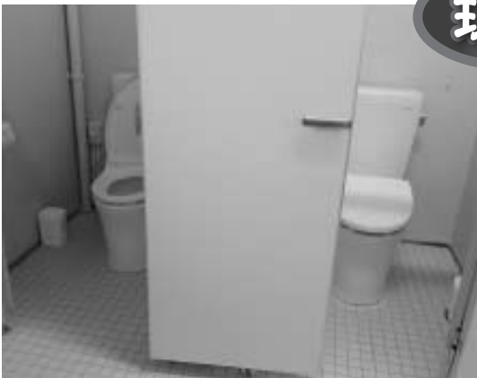
洋式に改修された村民体育館女子トイレ
