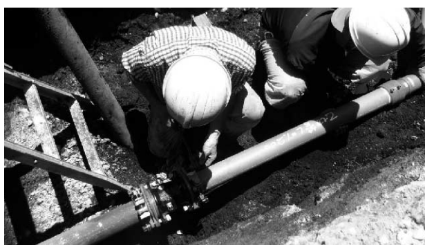
水道管布設替え
