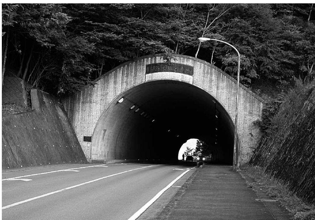
西湖文化洞トンネル
