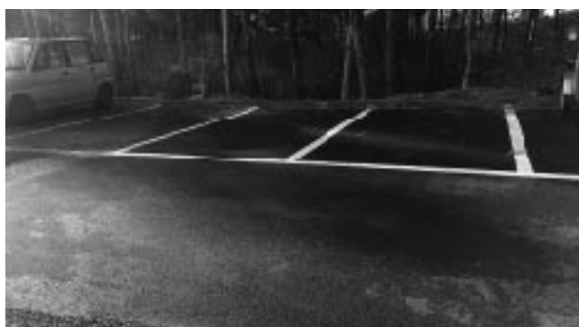
改修された陥没箇所
